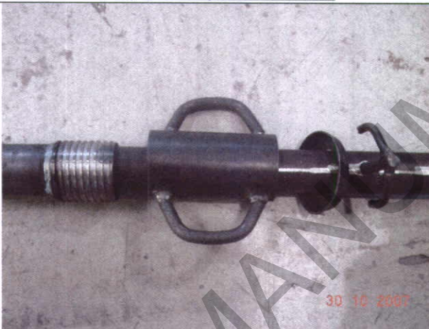
Fotografía 3: Detalle del sistema de regulación de altura.
